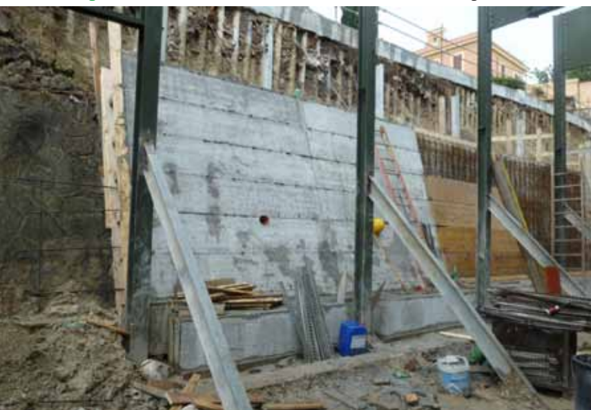
Figura 13 - La successione di armatura, cassetteratura e getto del muro
