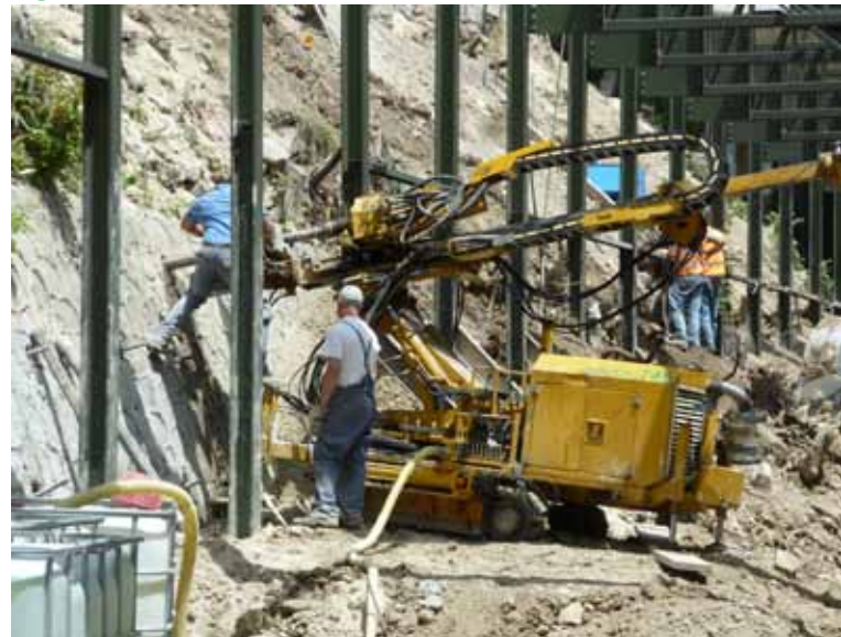
Figura 9 - Chiodatura del tratto di muro esistente non crollato
