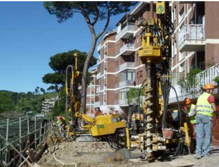
Figura 6 - Due macchine da micropali impiegate in serie per accelerare i tempi di esecuzione
