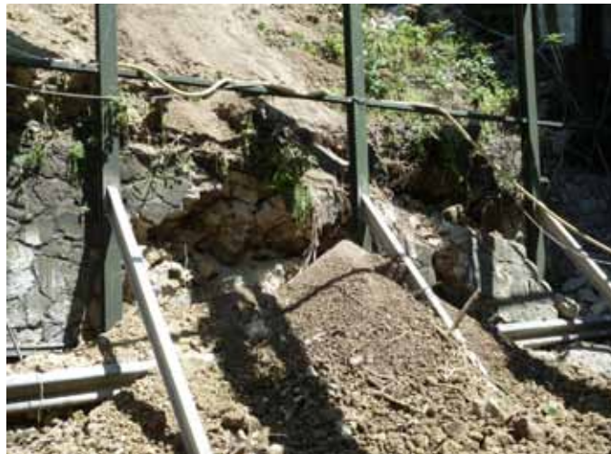
Figura 5 Il puntellamento della galleria anti-rumore
