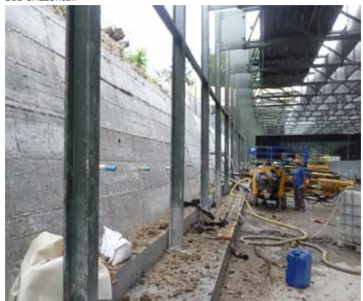
Figura 14 - Il muro completato e l'esecuzione dei microdreni sub-orizzontali
