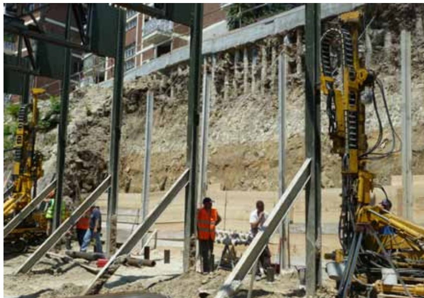
Figura 12 - L'esecuzione dei micropali di fondazione del nuovo muro
