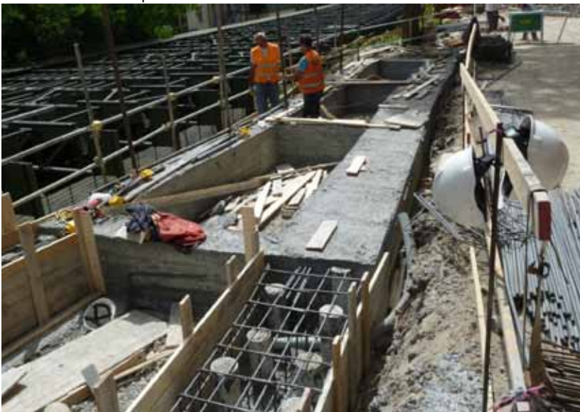
Figura 8 - L'esecuzione dei cordoli di collegamento delle paratie di micropali
