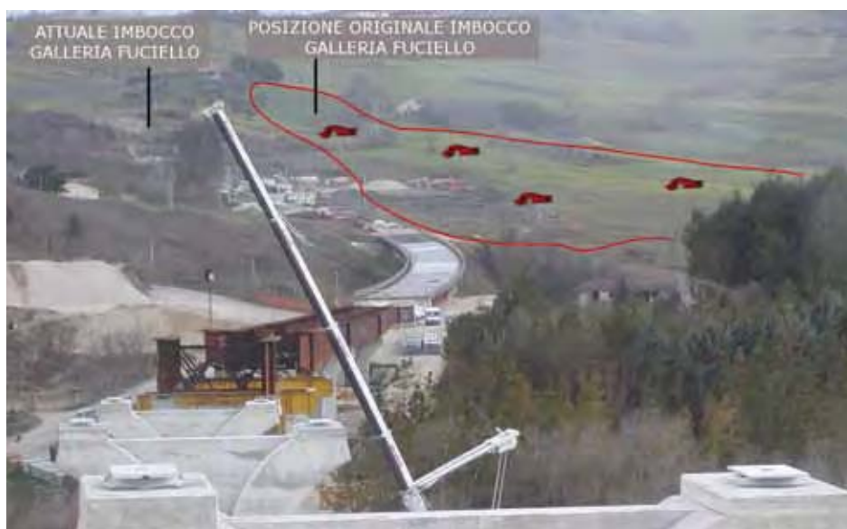
Figura 5 - Panoramica del Tammaro I (sul fondo, completato) e Tammaro II (in primo piano, in costruzione). I due viadotti sono separati da un breve tratto di rilevato. In alto in destra la frana evitata con la variante
