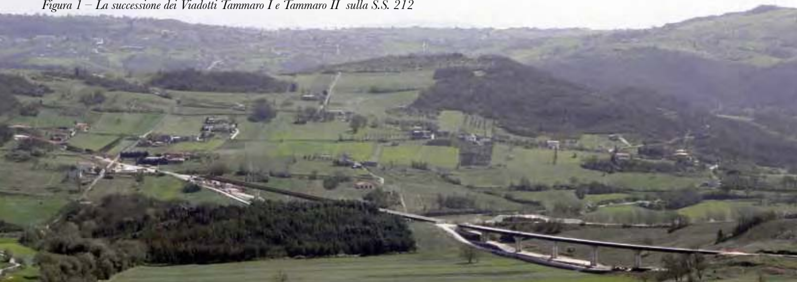
Figura 1 – La successione dei Viadotti Tammaro I e Tammaro II sulla S.S. 212
