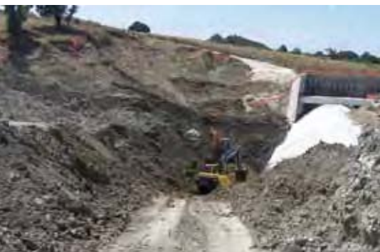
Figura 2 – Prolungamento di galleria artificiale
