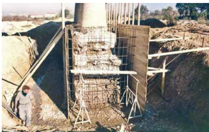
1A e 1B. Il rafforzamento delle fondazioni del ponte sul Fiastra del 1987
