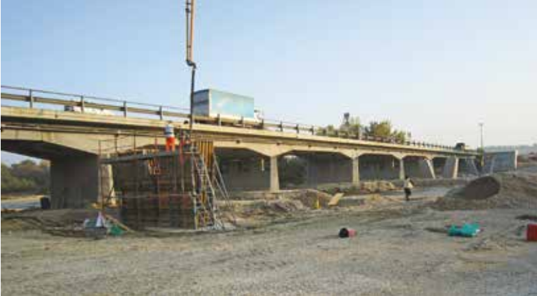
6. Il vecchio ponte a Montecosaro e il nuovo in costruzione
