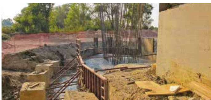
9. Le fondazioni del nuovo ponte in adiacenza all'esistente
