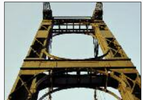
9. Le torri in acciaio del ponte
