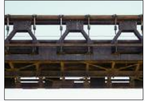
8. La carpenteria metallica dell'impalcato del ponte
