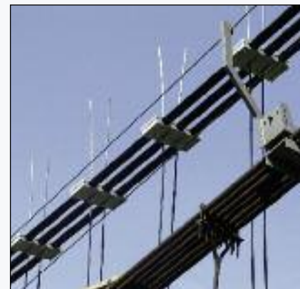
13. Un dettaglio delle clampe e dei cavi del ponte di Chiani
