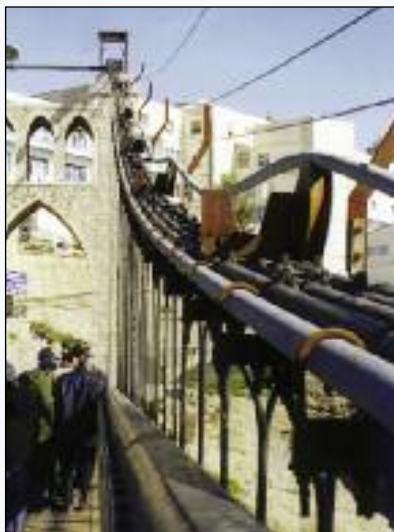
11. Le clampe sul ponte sospeso di Sidi M' Cid
