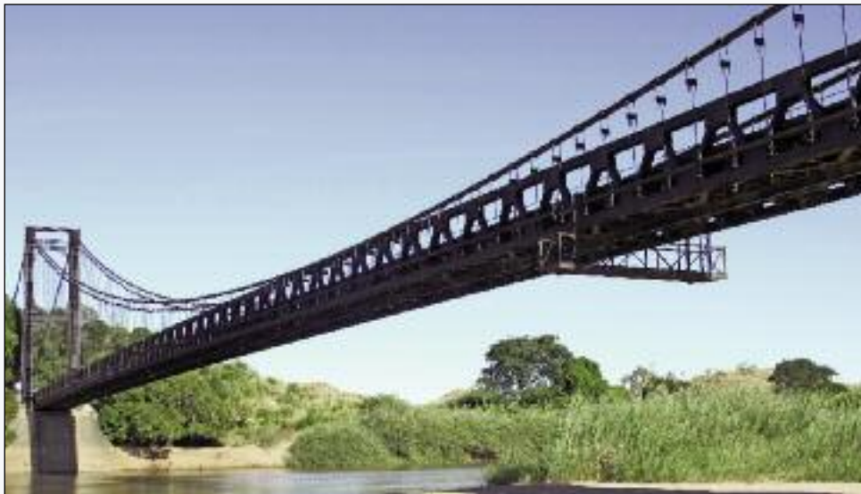
2. Una vista del ponte dal fiume
