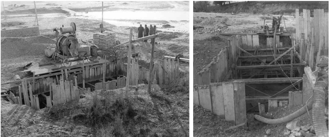
Figura 3 - Realizzazione delle fondazioni del ponte sul torrente Fiastra nel 1955
