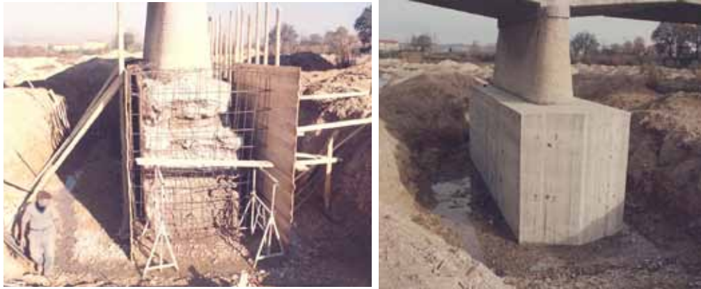
Figura 14 - Il rafforzamento delle fondazioni del ponte sul Fiastra del 1987
