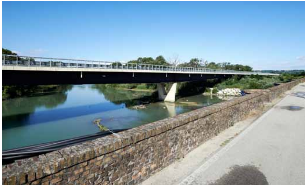
Figura 9 - Il nuovo ponte sul Sangro
