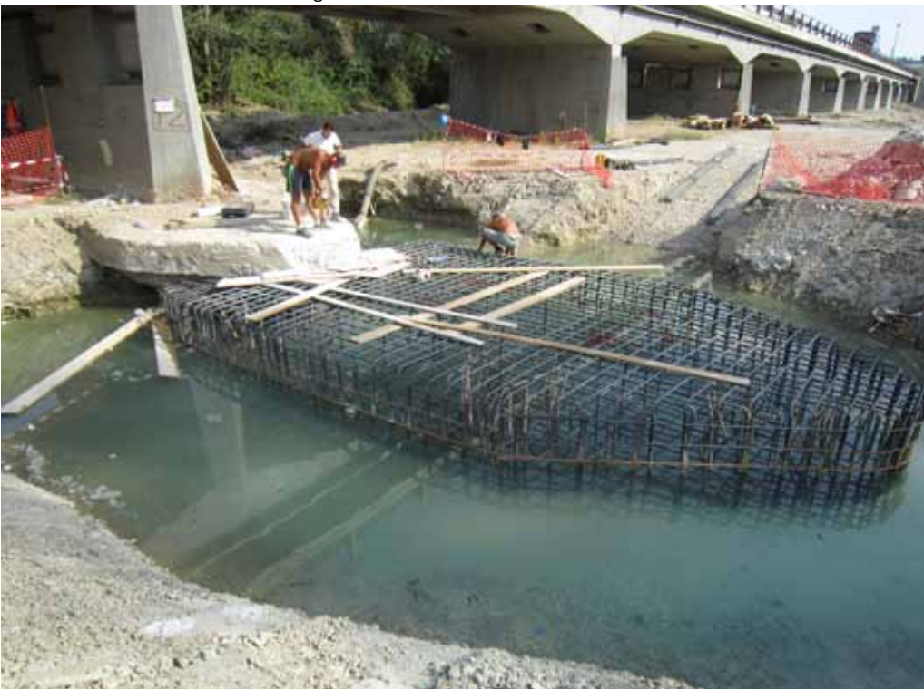
Figura 10 - Un plinto del nuovo viadotto in costruzione e sullo sfondo la Pila 3 del viadotto esistente rialzata in seguito allo scalzamento subito
