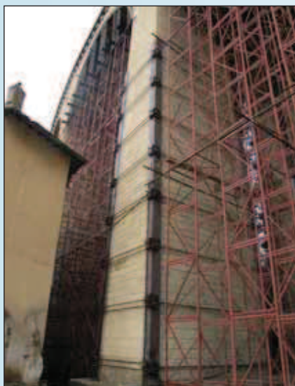
Рис. 10. Аварийная обстройка для усиления тела опоры прокатным металлом с внешним обжатием
