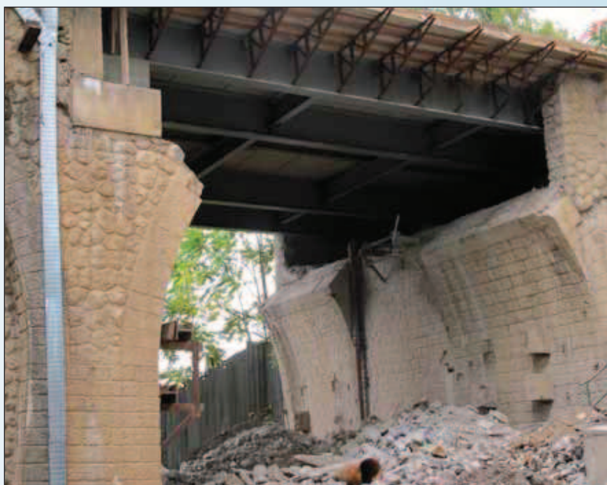
Рис. 9. Буферный пролет между устоем и промежуточной опорой 1
