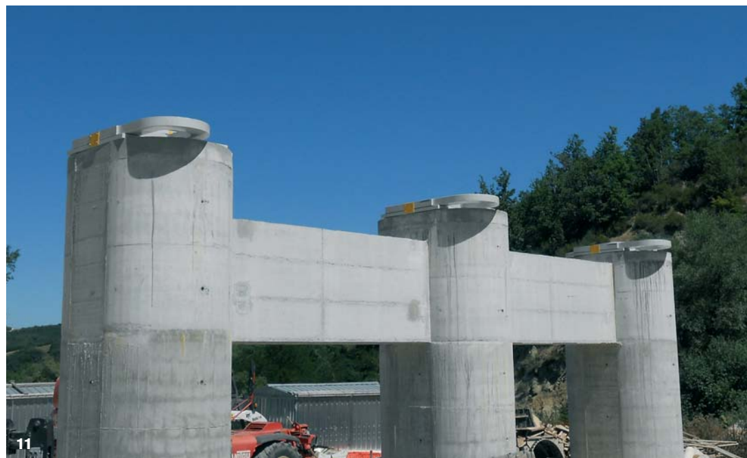
11. Dettaglio pila del Viadotto Ingotte II con i ritegni sismici integrati con gli appoggi
