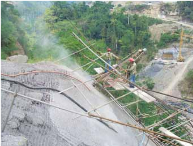
Foto 16 - La chiodatura del versante a valle della spalla sud
