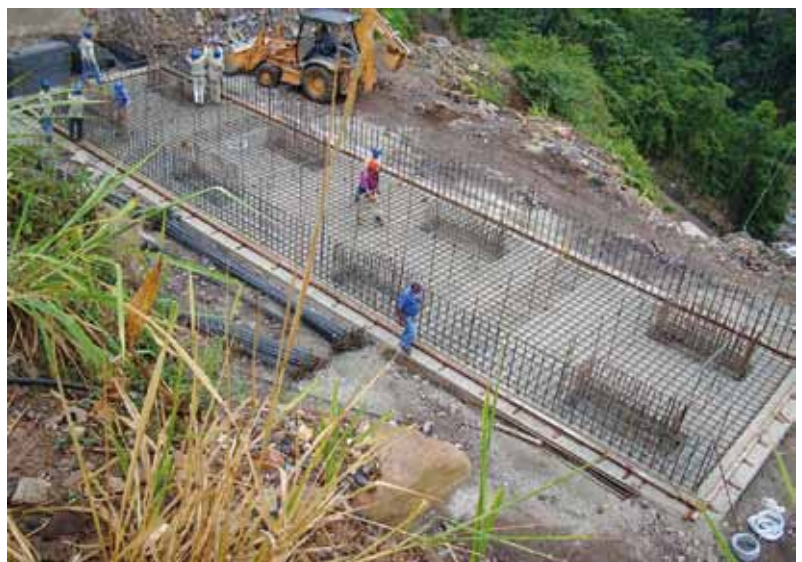
Foto 6 e 7 - Esecuzione dei diaframmi e armatura del plinto della spalla sud
