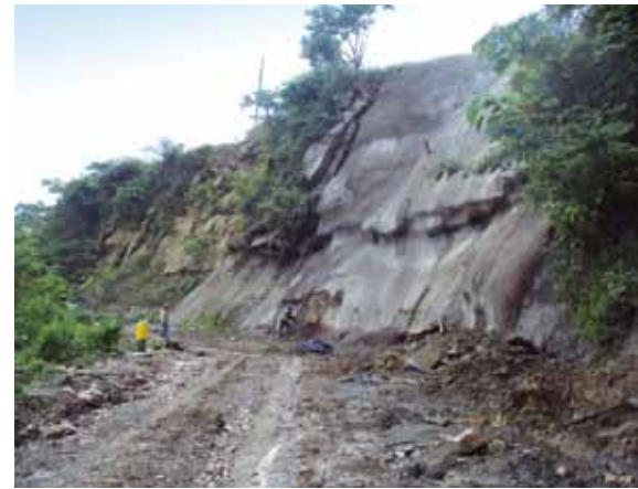
Foto 24 - 25 - 26 - 27 - I banconi di arenaria affetti da fenomeni di "toppling": prima (a sx) e dopo (a dx) dell'intervento di chiodatura
