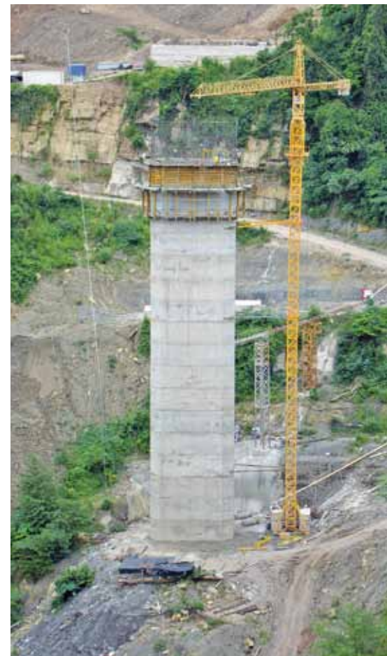
Foto 28 - La sponda destra con in primo piano la pila 2 in elevazione e in alto la spalla nord con gli interventi di chiodatura in corso
