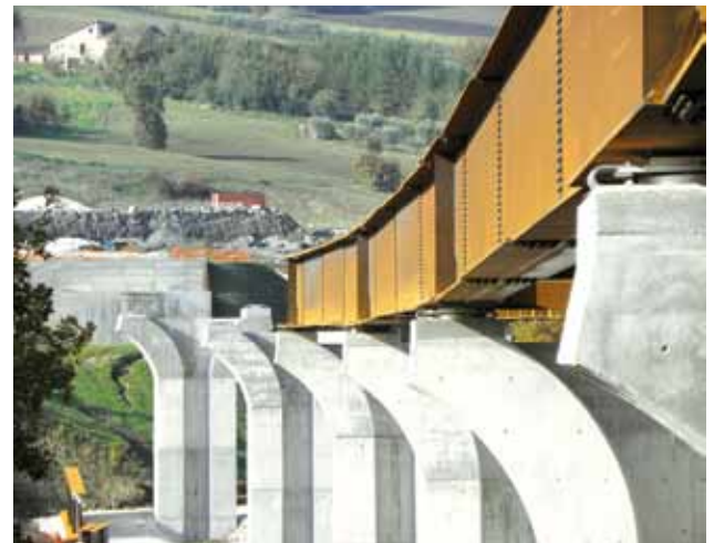
Figura 14 - Testa pila e impalcato del Tammaro I con gli appoggi dotati di ritegni elasto-plastici
