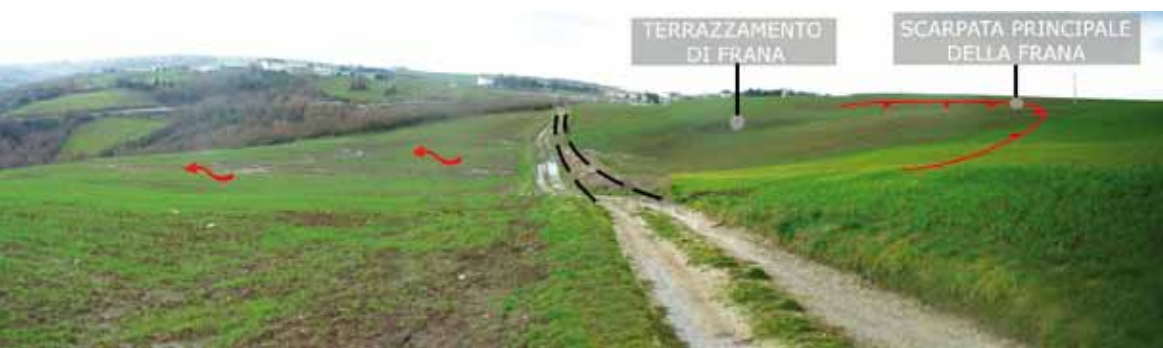
Figura 5 - Area del viadotto Lesce. Si nota la traslazione subita dal sentiero a seguito dei movimenti franosi
