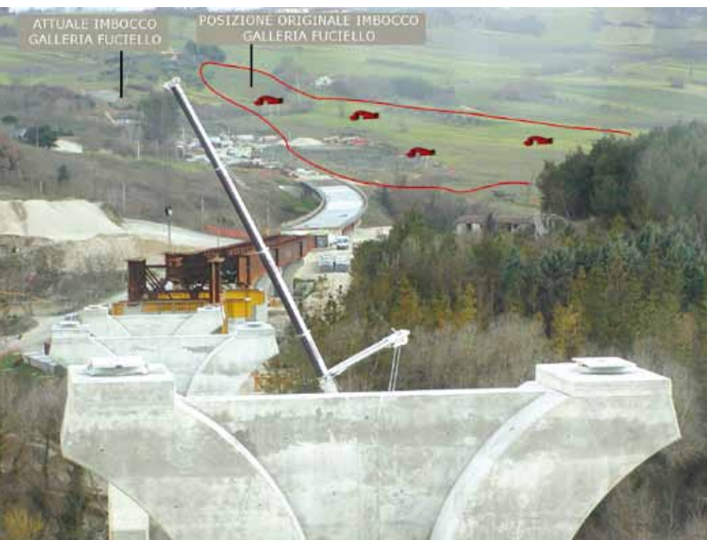
Figura 11 - Panoramica del Tammaro I (sul fondo, completato) e Tammaro II (in primo piano, in costruzione). I due viadotti sono separati da un breve tratto di rilevato. In alto in destra la frana evitata con la variante
