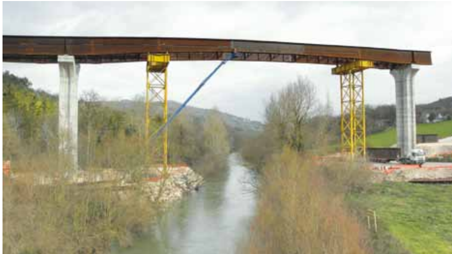
Figura 16 - Operazioni di serraggio dei bulloni sul concio di chiusura del Tammaro II
