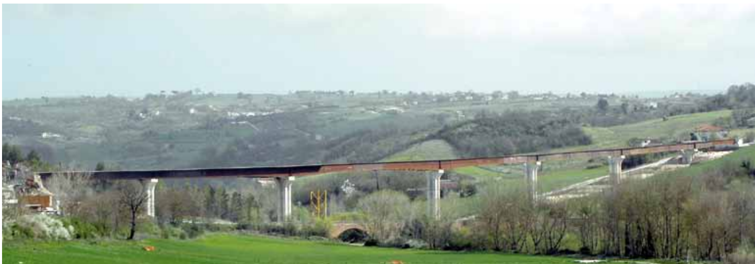
Figura 9 - Il Viadotto Tammaro II
