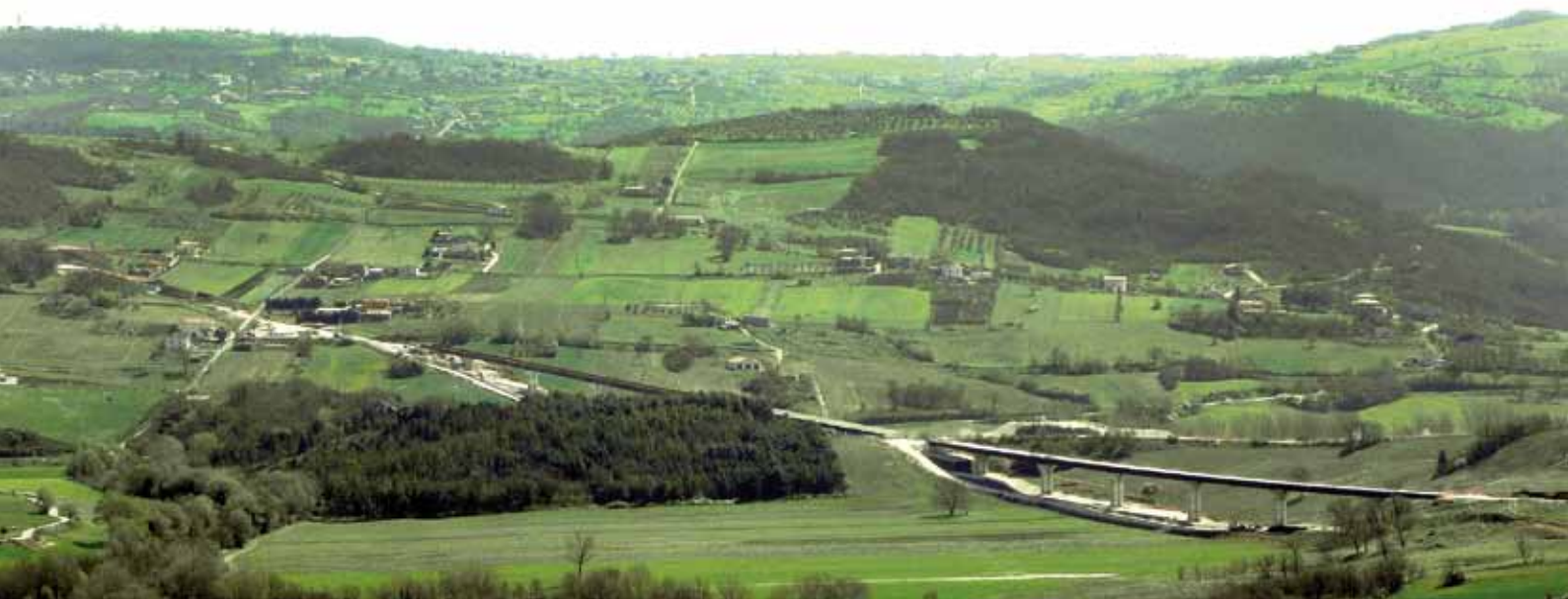
Figura 1 - La successione dei viadotti Tammaro I e Tammaro II sulla S.S. 212
