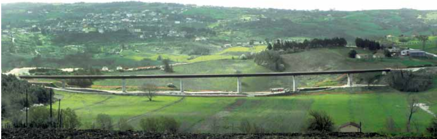
Figura 8 - Il Viadotto Tammaro I
