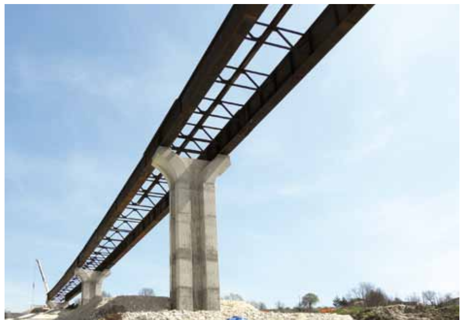
Figura 13 - Pila e pulvino del Tammaro II
