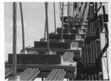
写真-5 新設の吊りケーブル構造
