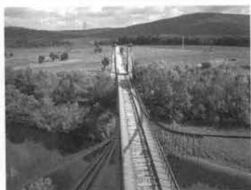
写真-1 補修前のシハニ橋
