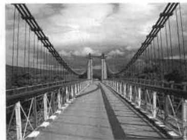
写真-8 補修後の橋面
