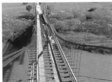
写真-6 横桁の補強および拡張状況
