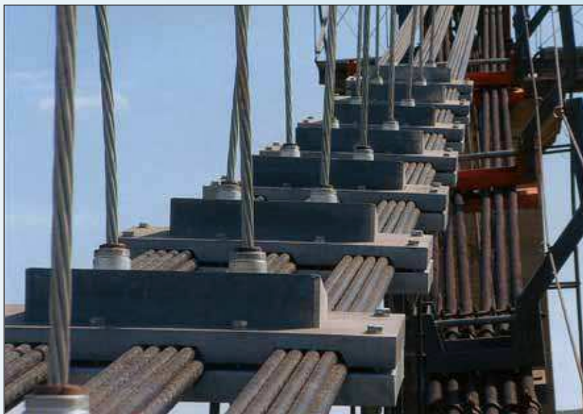
Рис. 9. Обжимающие обоймы
