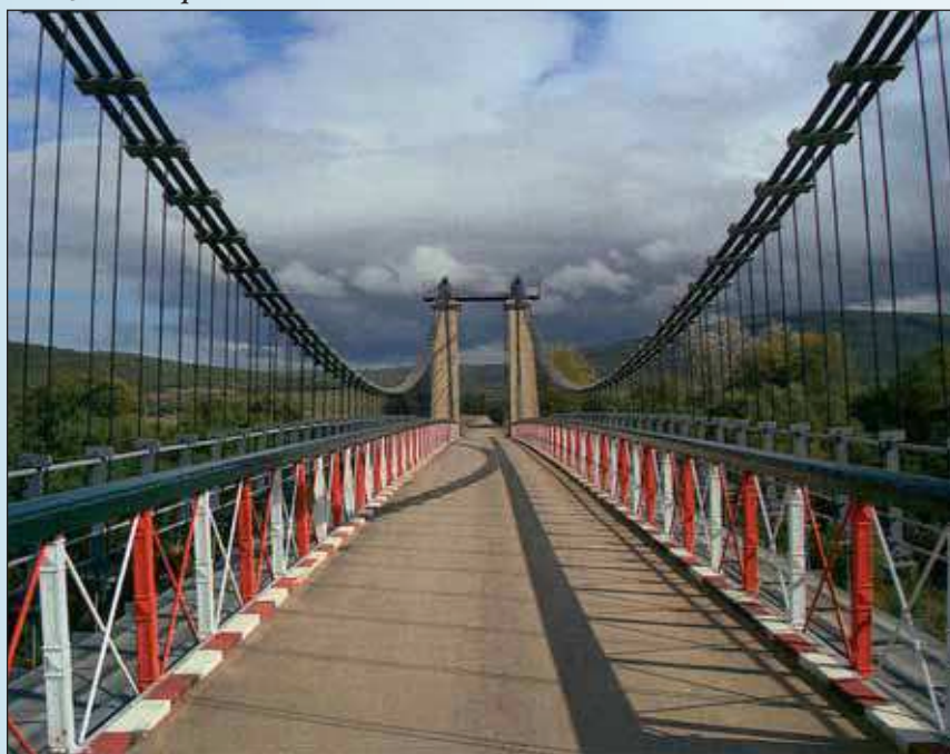
Рис. 15. Новая проезжая часть моста Чиани
