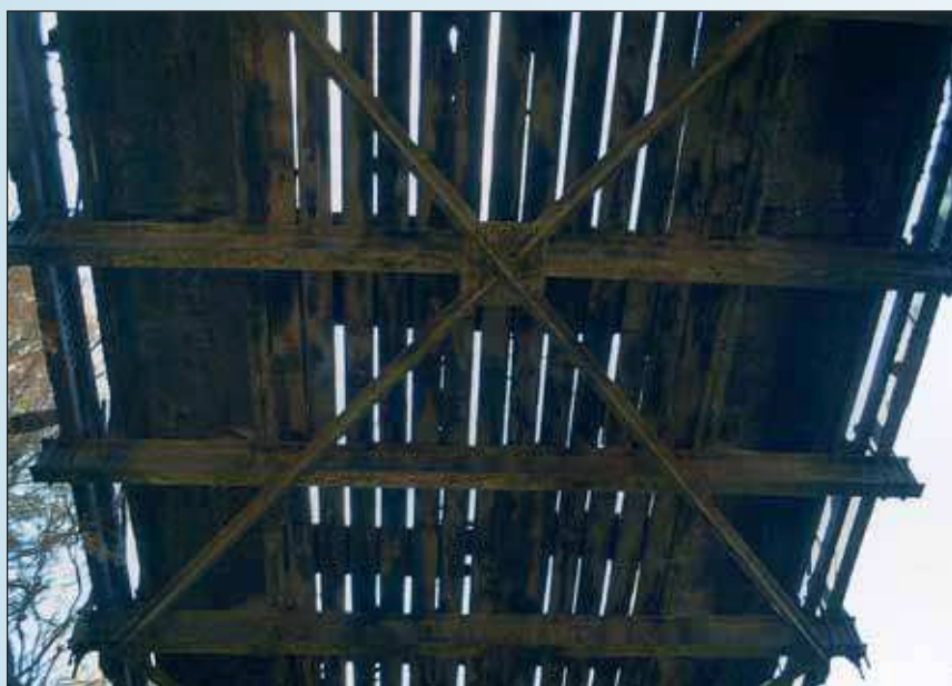
Рис. 5. Настил существующей проезжей части
