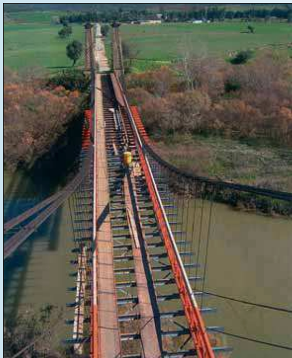
Рис. 11. Усиление и удлинение поперечных балок
