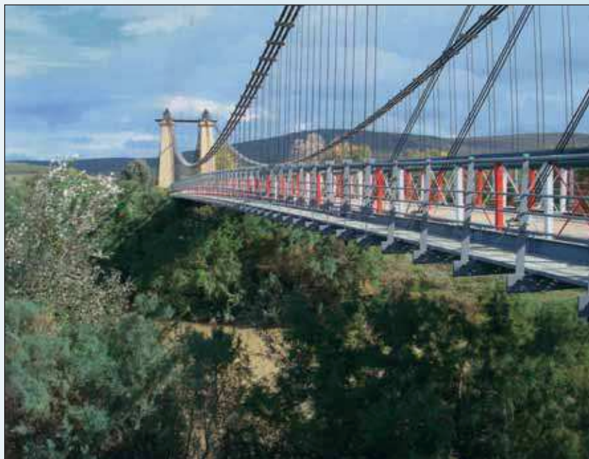
Рис. 16. Новый мост Чиани
