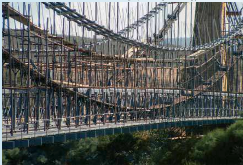
Рис. 12. Обе системы подвески до начала операции по передаче нагрузки
