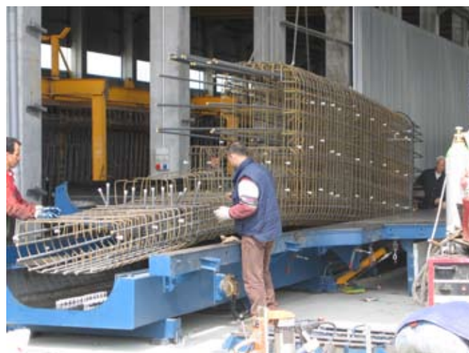
Foto 17 – Vista dei pilastri prefabbricati durante la costruzione della g.a. di Pregnana
