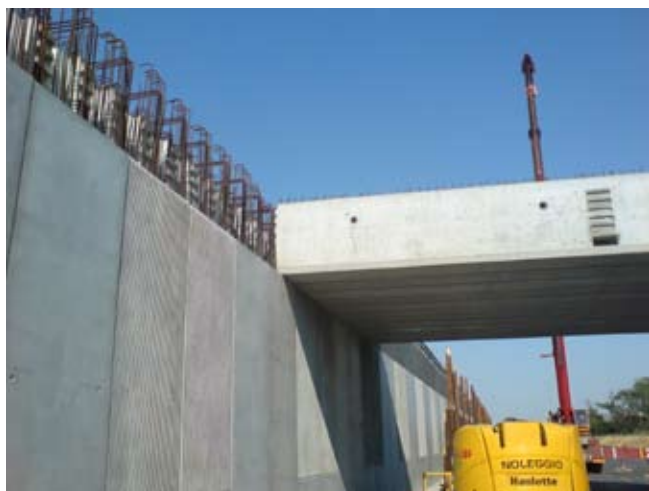
Foto 20 – Dettaglio di un nodo traveparete durante il montaggio
