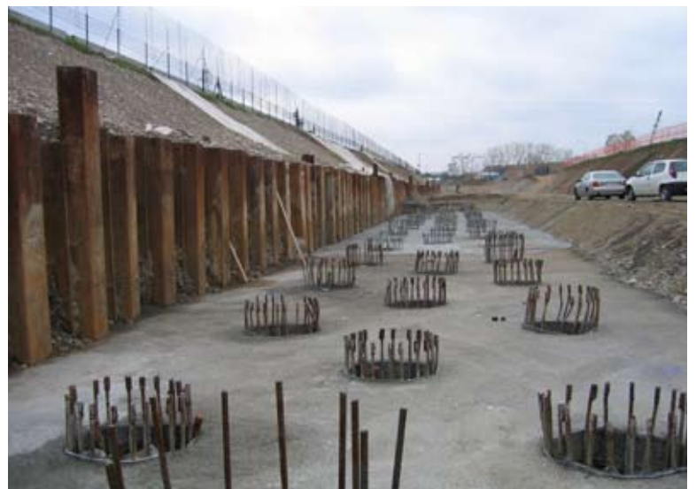
Foto 13 - Pali di fondazione della g.a. di Pregnana
