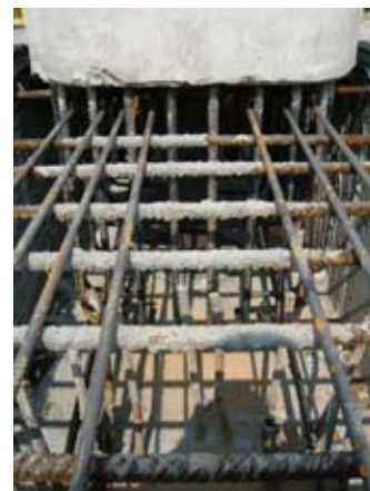
Foto 19 – Dettaglio di un nodo pilastro-fondazione prima del getto di collegamento
