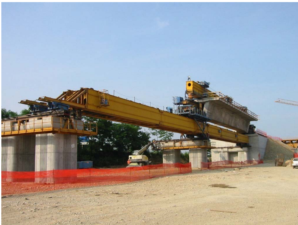
FOTO 10 - FASE DI VARO. MASSIMO INGOMBRO DEL SOTTOPONTE.
