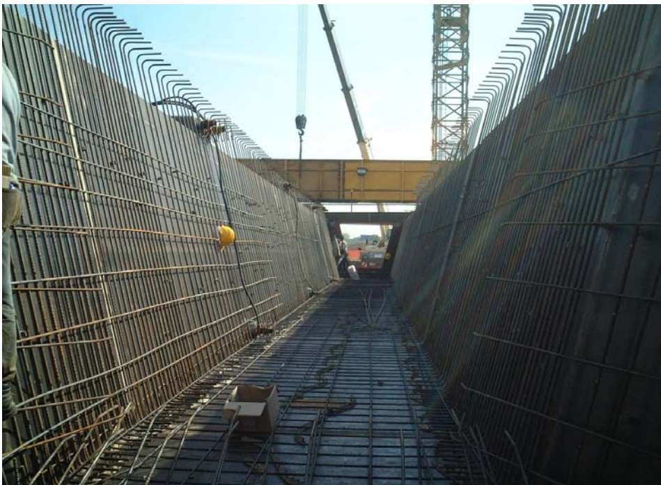
FOTO 4- POSIZIONAMENTO DELLA GABBIA NEL CASSERO.
