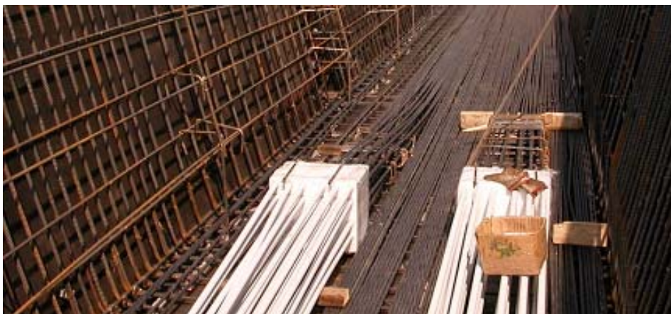
FOTO 2 - CASSETTE DI INERTIZZAZIONE E TREFOLI INGUAINATI.
