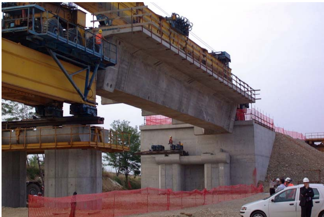
FOTO 9 - POSIZIONAMENTO DEL CASSONE SUGLI APPOGGI.
