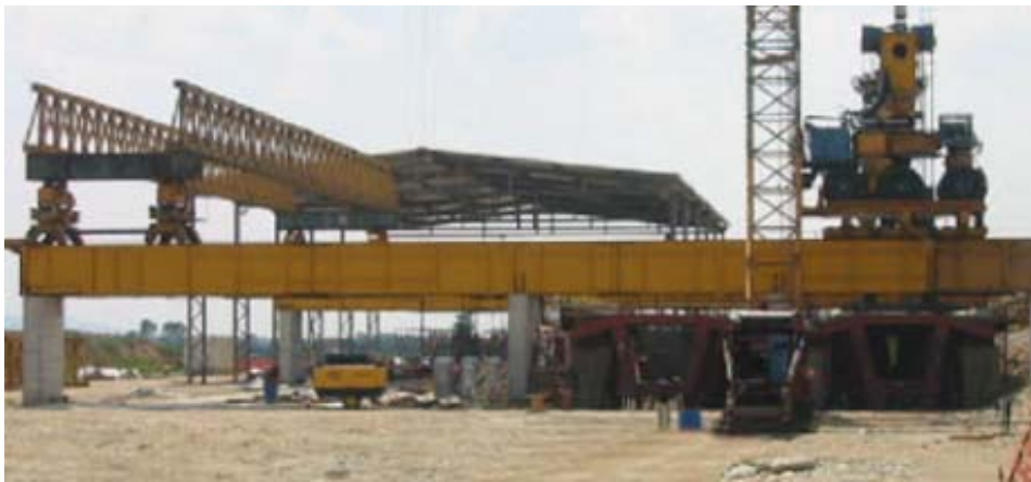
FOTO 3- L'IMPIANTO DI PREFABBRICAZIONE DI CHIVASSO IN FASE DI ALLESTIMENTO
