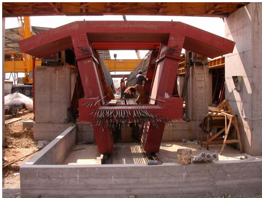
FOTO 5 - TESTATA DI TIRO PRIMA DELLE OPERAZIONI DI TESATURA.
