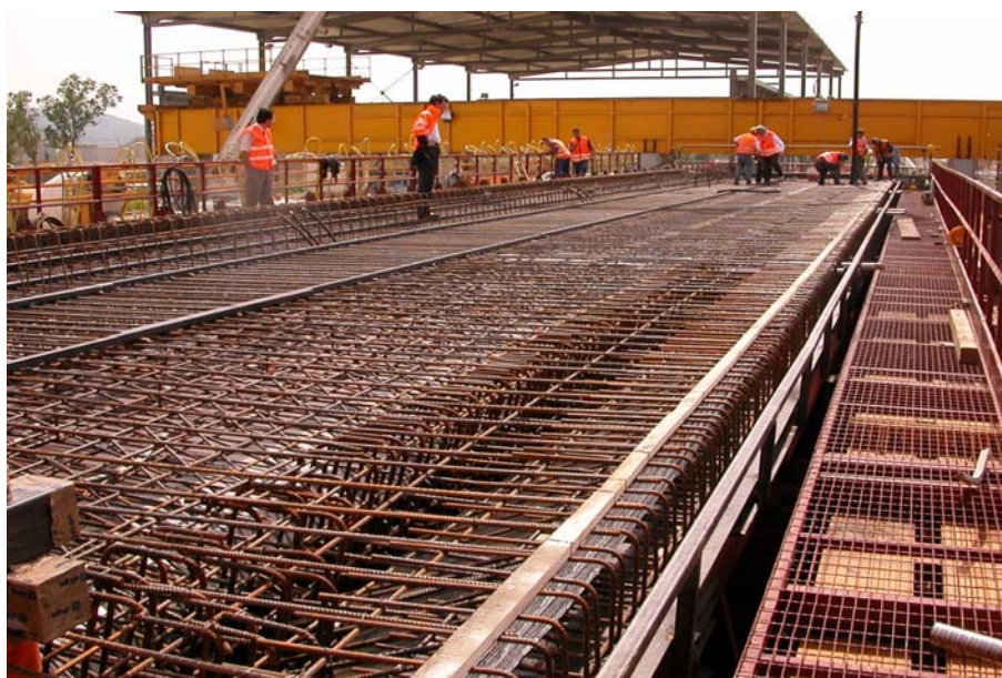
FOTO 6 - DISPOSIZIONE DELL'ARMATURA DELLA SOLETTA.
